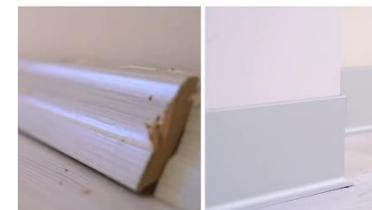
Установка в «запил» предполагает более высокую квалификацию установщика, так как необходимо нарезать плинтус точно и под нужным углом, чтобы избежать щелей в стыках.
